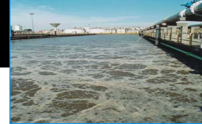
Tanque de aeração
